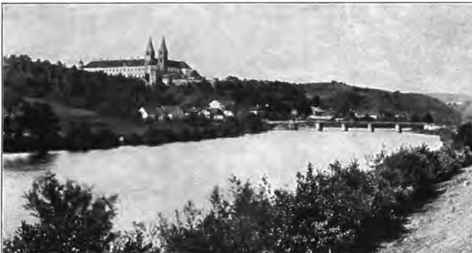
Fig. 83. Reichenbach. Nordostansicht des Klosters.
